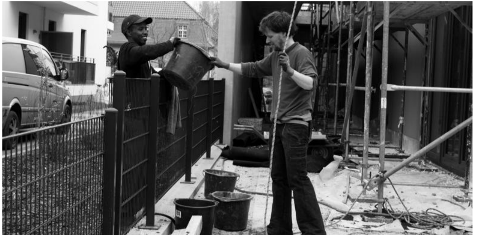
▲ Felix und Mohamed befördern die Eimer mit Erde zum Flaschenzug auf der Baustelle am Westend.
